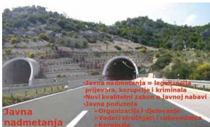
Tunel Crna brda u biokovskom zaleđu sa stajalištima o javnoj nabavi
