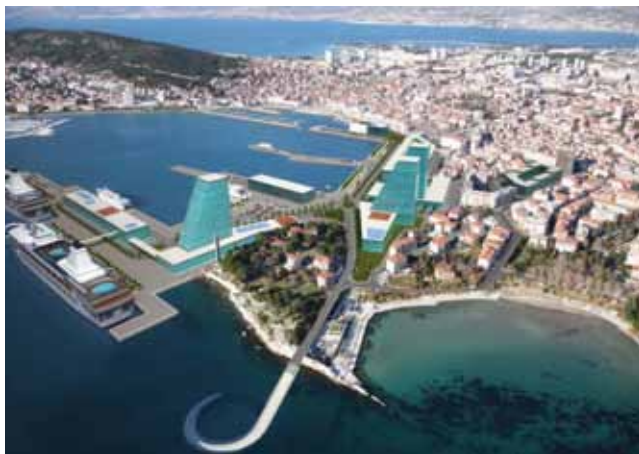
Podmorsko povezivanje Zadra i otoka Ugljana – rampa u zadarskoj luci
